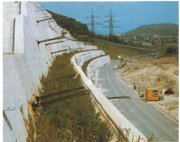
Stabilisierung einer Straßenböschung
