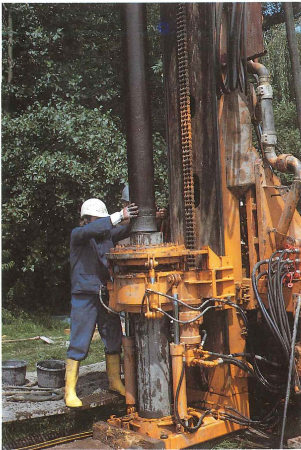
Kiesprospektion im Gebiet Mittlerer Oberrhein: Mittels Ventilbohrverfahren (Kiesbüchse) (links) werden 50-cm-Durchschnittsproben aus Tiefen bis 100 m gewonnen (rechts).
