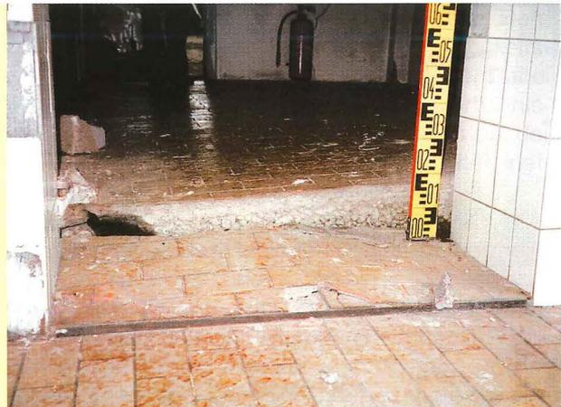
Abb. 27: Durch Baugrundhebung zerstörter Fußboden in einer Fabrikhalle im Zollernalbkreis
