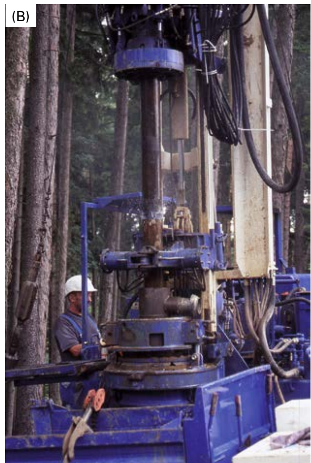
Abb. 6.2-4: Kernbohranlagen auf Raupenfahrzeugen ermöglichen auch in schwierigem Gelände die rasche Gewinnung von Bohrkernen bis ca. 100m Tiefe: (A) Kernbohrung oberhalb eines alten, verbrochenen Steinbruchs. (B) Raupenbohrgerät bei der Erkundung in aufschlusslosem Waldgelände.
