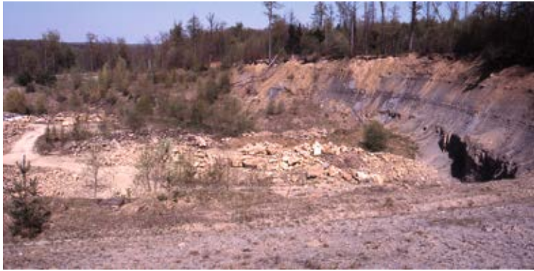
Abb. 6.1-2: Schon wenige Jahre nach Einstellung der Werksteingewinnung beginnen aufgrund herrschender Klimabedingungen in unseren Breiten die Steinbrüche zu verbrechen, insbesondere wenn tonige Schichten über dem Werksteinlager aufgeschlossen wurden. Etwa ein Jahrzehnt nach Einstellung des Abbaus ist das ehemalige Steinbruchgelände vollständig überwachsen. Eine spätere Beurteilung der einst genutzten Lagerstätte ist dann kaum mehr möglich. Zum Zeitpunkt der Aufnahme seit zwei Jahren aufgelassener Steinbruch im Rhätsandstein bei Tübingen.
