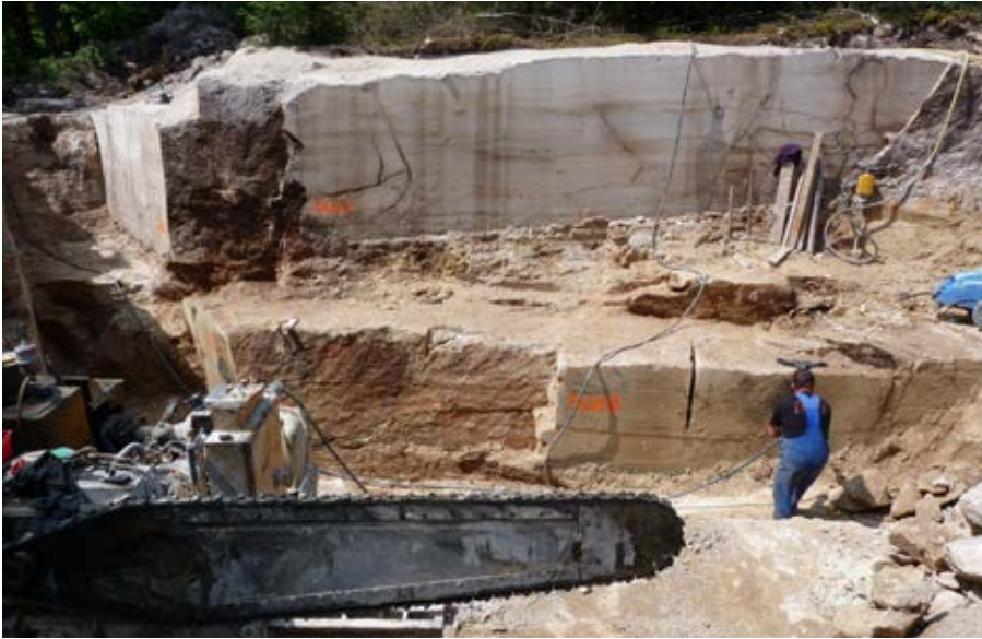
Abb. 6.2-8: Probeabbau mit der Schwertsäge. Der durch Kartierung und Kernbohrungen vorbereitete, 4m tiefe Einschnitt im Stubensandstein erlaubt die verlässliche Beurteilung hinsichtlich der Eignung des Gesteins und der gewinnbaren Blockgrößen. Die dabei gewonnenen Blöcke dienen der Untersuchung im Labor und in der Steinmetzwerkstatt.
