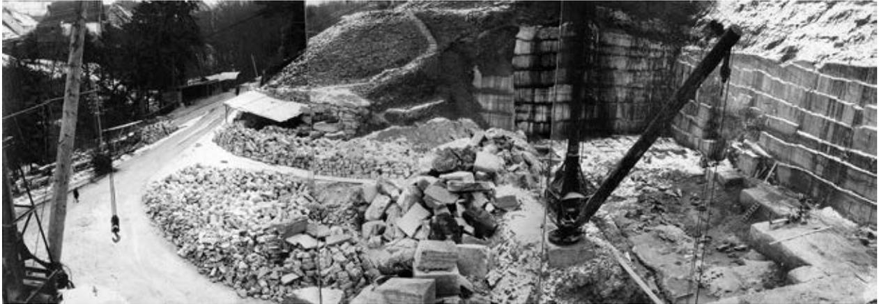
Abb. 4.20-7: Abbau von Randengrobkalk im Vorderen Steinbruch durch die Fa. A. Lauster (Foto vom Februar 1939), links im Hintergrund die Häuser von Tengen. Auf acht Teilsohlen wurde der bis 14m mächtige Kalkstein mittels Schwertsäge abgebaut.
