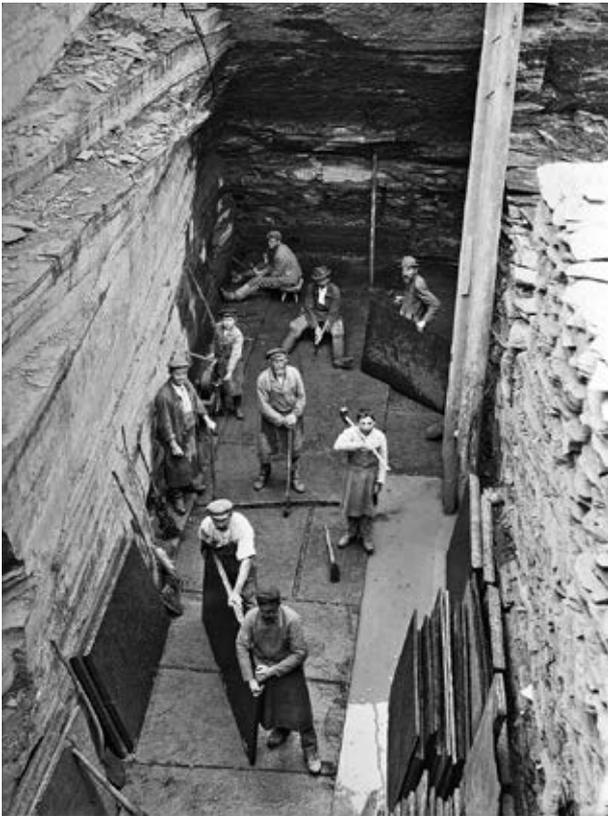
Abb. 4.19-9: Gewinnung von Posidonienschieferplatten bei Holzmaden um 1900; die Platten werden händisch abgebaut und zugerichtet.
