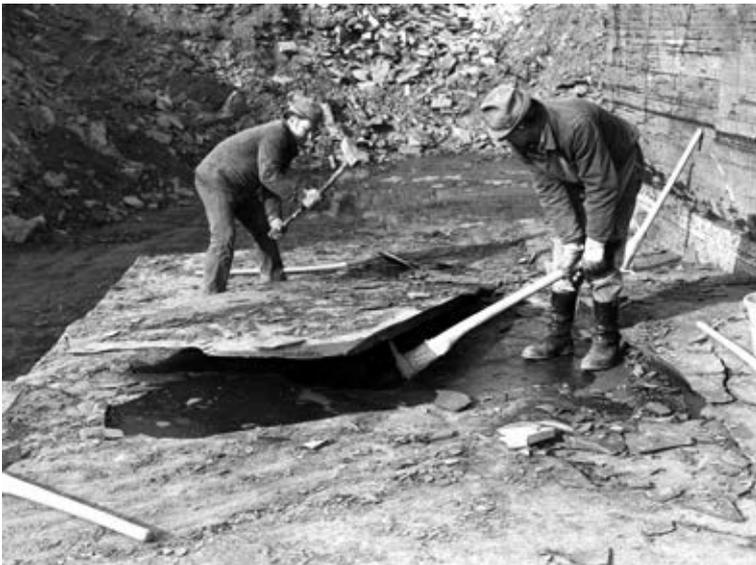
Abb. 4.19-12: Herausbrechen des Posidonienschiefers im Steinbruch Ohmden I (RG 7323-2), ca. 50er Jahre.
