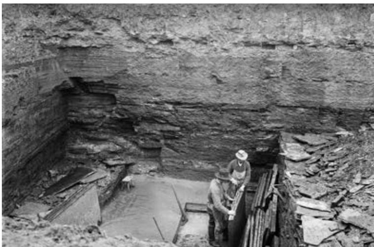
Abb. 4.19-10: Historische Gewinnung von Posidonienschieferplatten; die Abbaue wurden als nur wenige m breite und lange „wandernde Steinbrüche“ betrieben, der Abraum wurde von der Abbaufront auf die gegenüberliegende Steinbruchseite umgeschichtet.
