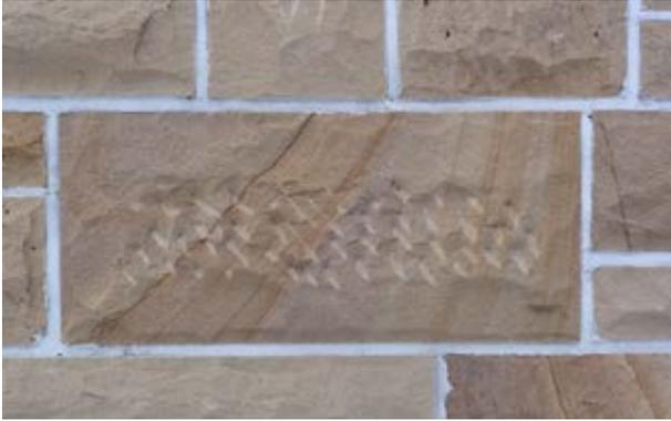
Abb. 4.21-9: Mauerquader aus Rhätsandstein mit typischer Bänderung und Fleckung durch Limonit.
