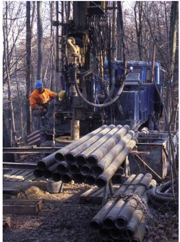
Abb. 4.17-26: Erkundungsbohrung, durchgeführt 2010 oberhalb des östlichen Steinbruchs. Mit der Kernbohrung wurde der Gesteinsaufbau der einst genutzten Lagerstätte ermittelt und geprüft, ob hinter den verschütteten Steinbruchwänden noch Pfaffenweiler Kalksandstein in Werksteinqualität vorhanden ist.
