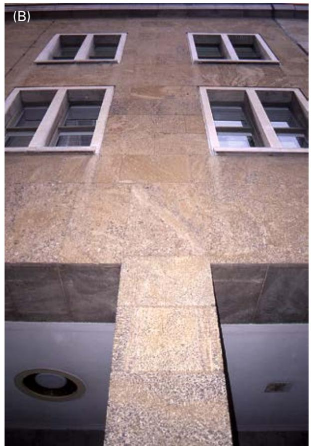
Abb. 4.20-13 (A und B): Flughafengebäude in Berlin-Tempelhof, errichtet 1936–1941, Fassadenplatten aus dem Vorderen Steinbruch der Fa. Lauster in Tengen (Foto 2010).
