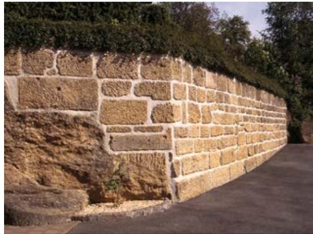
Abb. 4.20-10: Gartenmauer aus Randengrobkalkquadern, gebaut unmittelbar auf den Abbaustufen eines alten Steinbruchs am Ostrand von Tengen.
