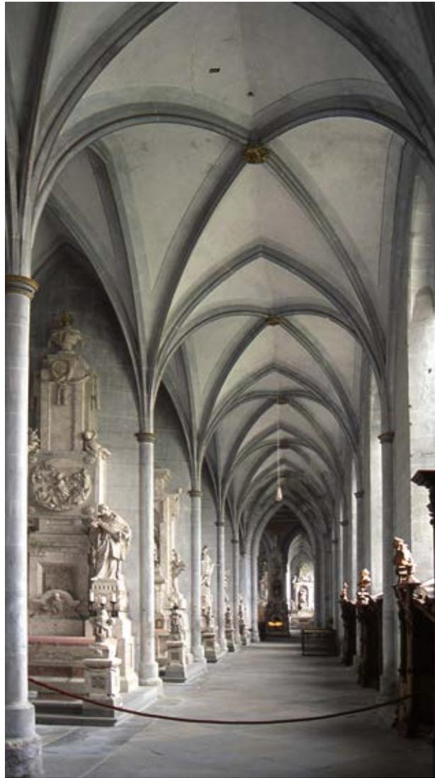
Abb. 4.20-20: Salemer Münster, im Zeitraum 1285–1420 vollständig aus grauem Molassesandstein errichteter Sakralbau mit gotischem Kreuzrippengewölbe.
