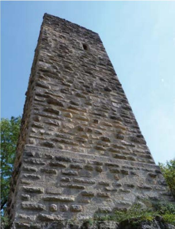
Abb. 4.20-9: Bergfried der Staufenburg von Tengen mit Buckelquadern aus Randengrobkalk.
