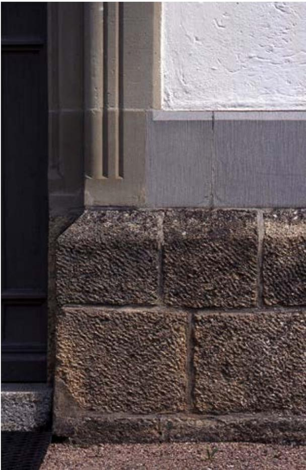
Abb. 4.20-14: Eine nicht seltene Werksteinkombination im südlichen Baden-Württemberg: Sockelsteine aus Randengrobkalk, Mauern und Türgewände aus Molassesandstein. Kirche St. Martin in Riedöschingen (Foto 2009).
