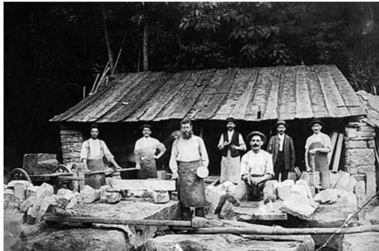
Abb. 4.17-22: Steinhauer vor ihrer Hütte im Betrieb von ALOIS ECKERLE (Mitte, in dunkler Weste) im Eichwald, Foto um 1910. Links im Bild ein Arbeiter mit Handkarren, auf dem zwei Rohblöcke von Pfaffenweiler Kalksandstein liegen.
