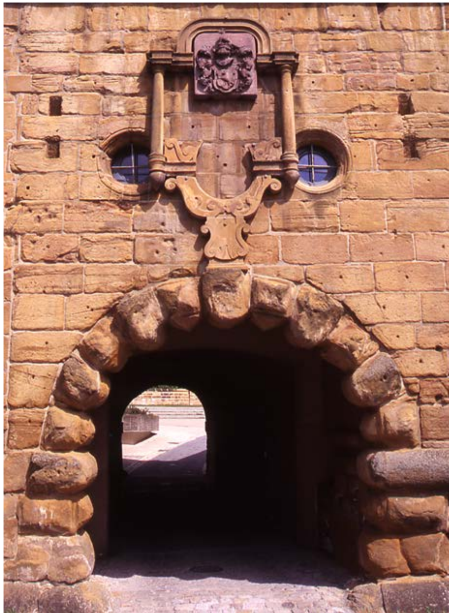
Abb. 4.7-1: Der Eisensandstein Ostwürttembergs in typischer Beschaffenheit und Verwendung – als haltbarer Mauerstein und als fein zu bearbeitender Ornamentstein. Für das im 16./17. Jh. im Stil der Renaissance erbaute Bollwerk der Kapfenburg bei Lauchheim haben die Baumeister konsequent darauf geachtet, dass die Schichtung der Sandsteinquader stets senkrecht zur Richtung des größten Drucks orientiert ist.
