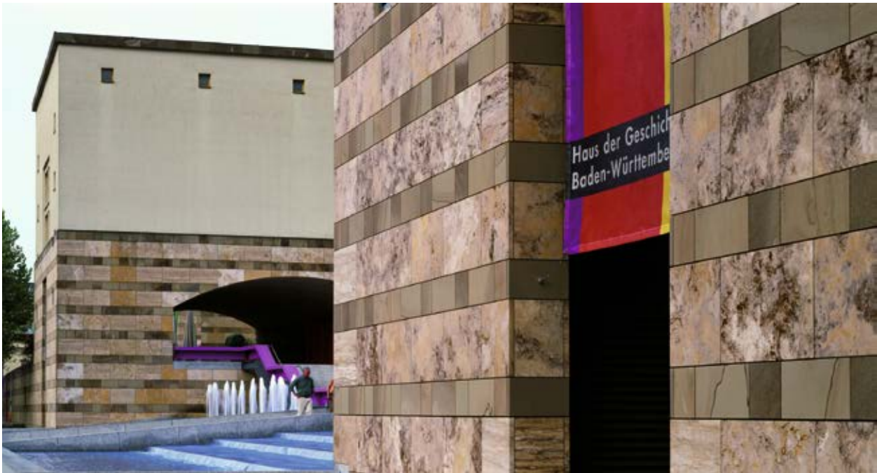
Abb. 4.6-18: Fassadenplatten aus Cannstatter Travertin im regelmäßigen Wechsel mit Schilfsandstein aus Sinsheim-Weiler, Sockel aus Granit; Stuttgarter Staatsgalerie; das 1984 fertiggestellte Bauwerk im Stil der Postmodernen Architektur wurde vom Londoner Architekturbüro James Stirling, Michael Wilford & Associates entworfen ( http://de.wikipedia.org/wiki ).
