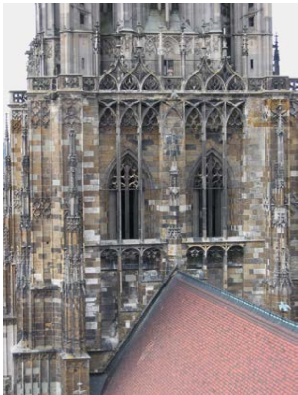
Abb. 4.7-14: Hauptturm des Ulmer Münsters, mittelalterlicher Teil, Ostseite. Braun die bauzeitlichen Eisensandsteinquader, hellgrau die bei der Renovierung im 20. Jh. ausgetauschten Quader aus Muschelkalk.
