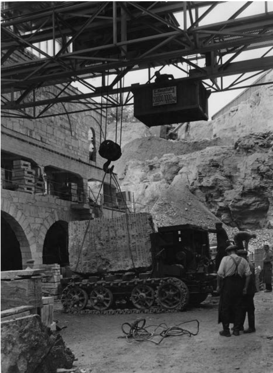
Abb. 4.6-12: Blockanlieferung im Werk der Fa. A. Lauster um 1939; ein durch Bohren und Keilspalten gewonnener Block wird auf einem Kettenfahrzeug angeliefert und mit Hilfe eines Brückenkrans abgeladen.
