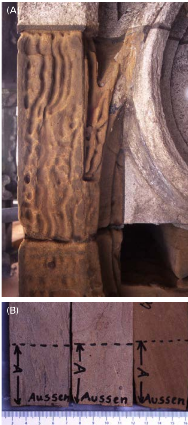
Abb.4.7-7: Eisensandstein vom Hauptturm des Ulmer Münsters: (A) Stark absandende, ferritisch gebundene Varietät im oberen Bereich des mittelalterlichen Turmabschnitts neben Muschelkalk. (B) Zur Untersuchung des Mauerwerks entnommene Bohrkerne; links im Bild helle, karbonatisch gebundene Sandsteine, vermutlich aus Donzdorf, rechts haltbarer, ferritisch gebundener Sandstein.
