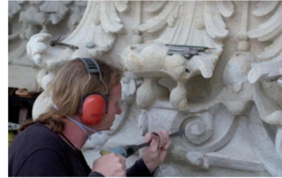
Abb. 3.2-42: Nachbearbeitung eines vom Fräsroboter vorgefertigten, filigranen Säulenkapitells aus Kreidesandstein. Fa. Bamberger Natursteinwerk Hermann Graser.
