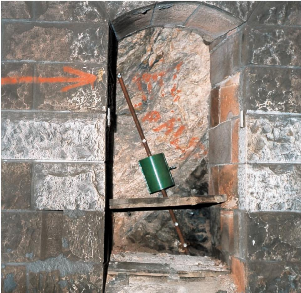
Abb. 14: Östliche Hauptverwerfung des Oberrheingrabens im Lorettotunnel der Höllentalbahn
