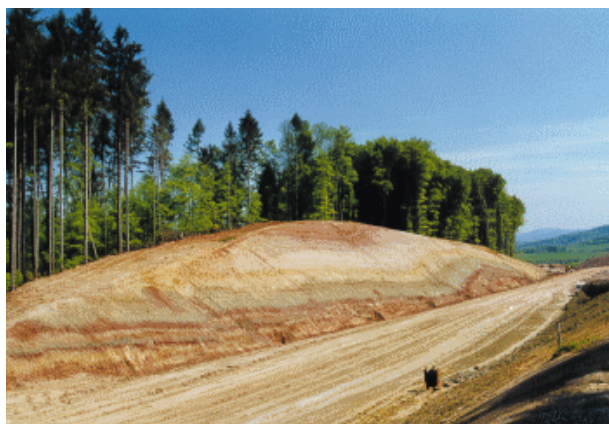
Abb. 18: Einschnitt beim Bau der Autobahn A 98 in den Dinkelberg (beim Waidhof nahe Lörrach, Lkr. Lörrach) Das Profil reicht vom Schilfsandstein (links unten) bis zu den Oberen Bunten Mergeln (an der Kuppe; Aufnahme Mai 1998).
