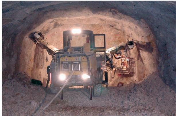
Abb. 8: Untertägige Gewinnung von hochreinen Kalksteinen („Ulmer Weiss“) im Mähringer Berg bei Blaustein (Beginn der Auffahrung des Gabriele-Stollens im Jahr 2000). Die untertägige Gewinnung ermöglicht eine selektive Gewinnung der hochreinen Partien der Massenkalksteinlagerstätte
