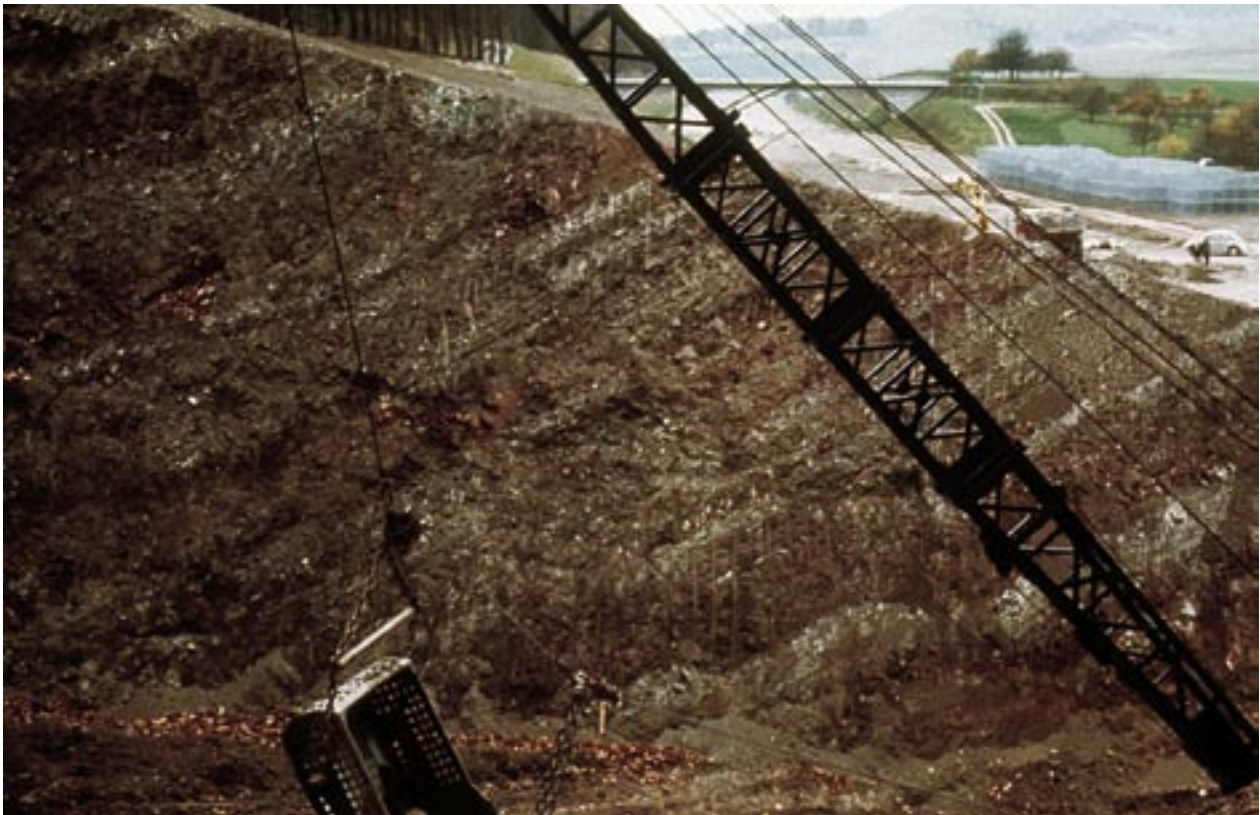
Abb. 27: Bergwärts einfallende Schichtung an einer Großschollenrutschung im Gipskeuper des Wildenbergs (Foto BRUDER)
