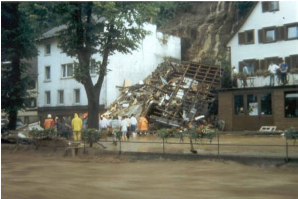
Abb. 22 : Durch einen Murgang zerstörtes Haus in Oppenau, Straßburger Straße 28 (Foto KÜHNLE)
