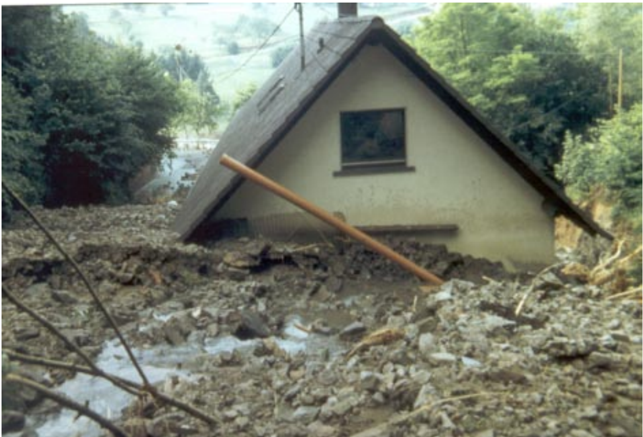
Abb. 21: Im Schutt einer Mure begrabenes Haus im Rußdobel („Allmend“) nordöstlich Oppenau (Foto KÜHNLE)
