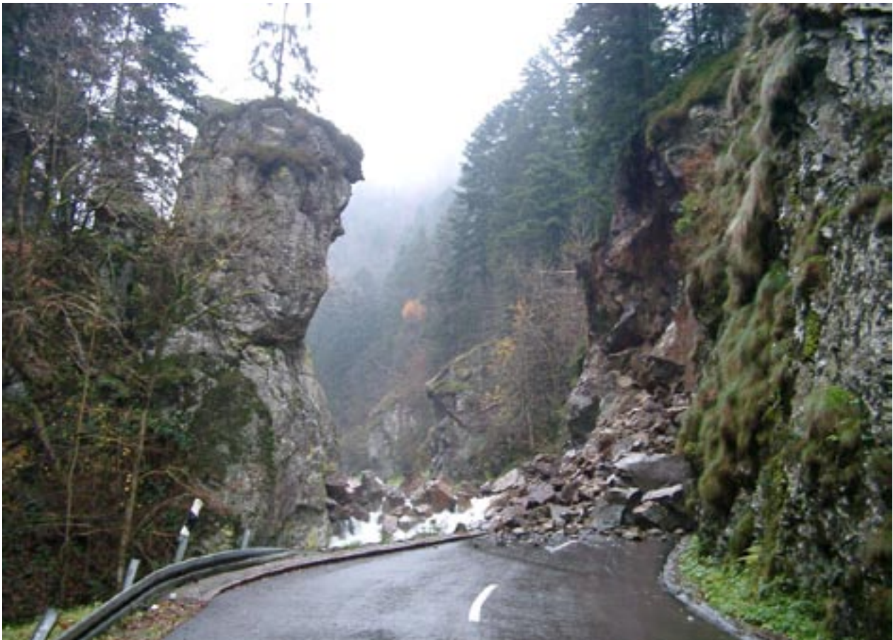
Abb. 20: Felssturz im Wehratal (Foto RUCH)
