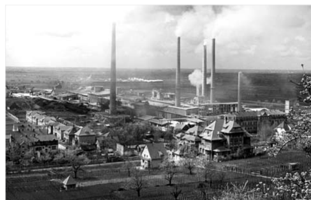
Abb. 139 Ansicht des Zementwerks in Leimen bei Heidelberg im Jahr 1960 (aus: www.heidelbergcement.com ).
