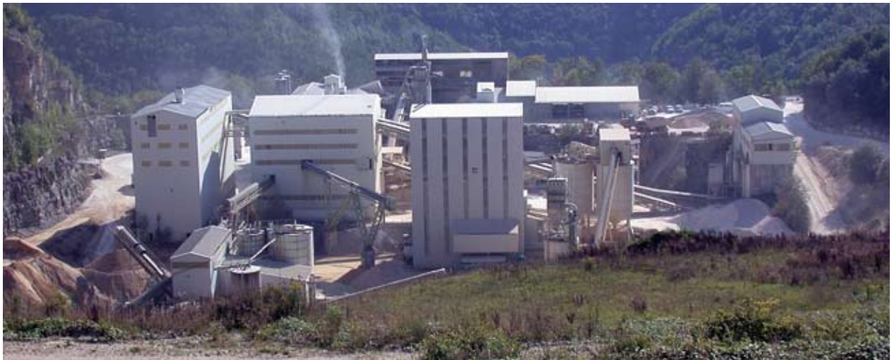
▲ Abb. 121 Aufbereitung in einem Kalksteinbruch auf der Schwäbischen Alb mit neuen Anlagen zur Erzeugung von Körnungen für den Verkehrswegebau, von Putzen und Granulaten für den Umweltschutz, Futtermittelzusatz u. v. m., Anlage bei Lennigen (RG 7422-2).
