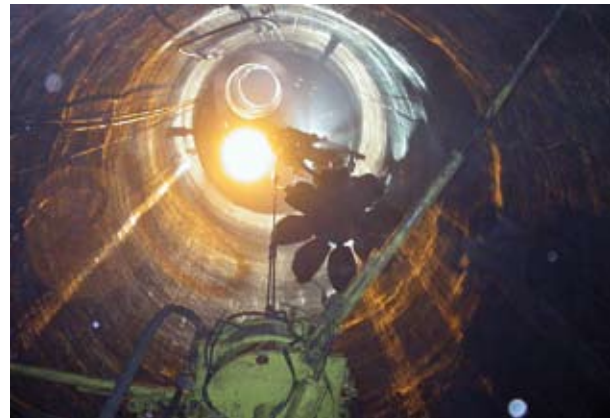
Abb. 173 Blick in die Schachtröhre am Konradsberg beim Bau des Schachtes 2003.
