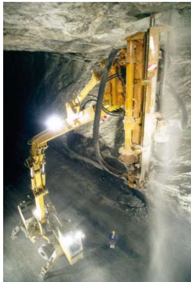
Abb. 168 Bohrlafette in einer Abbaukammer des Steinsalzbergwerkes Heilbronn.
