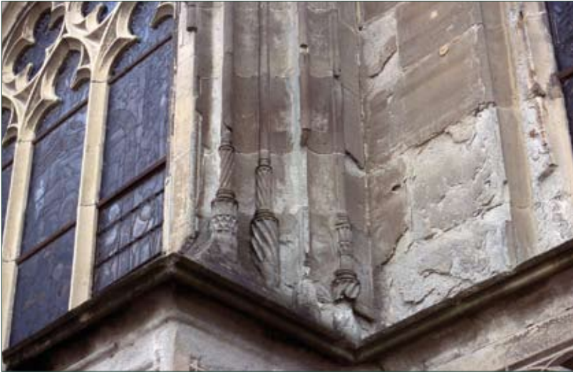
◀ Abb. 70 Durch Umwelteinwirkungen stark angegriffener Molassesandstein am Konstanzer Münster.
