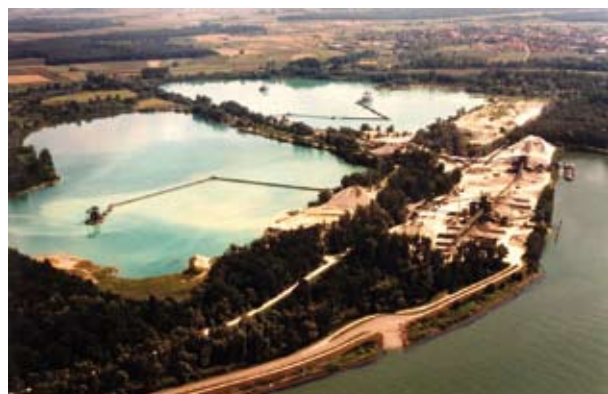
Abb. 13 Luftbild der Kiesgruben Neuried-Ichenheim (RG 7512-1) und Meißenheim (RG 7512-2) mit Aufbereitungsanlagen und angrenzendem Rheinhafen (rechts).
