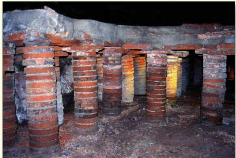
Aus Tonziegeln gemauertes Hypocaustum im sog. Soldatenbad in Baden-Baden.
