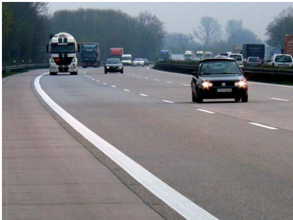
Abb. 219: Waschbetonerprobungsstrecke BAB A5 zwischen Rastatt und Baden-Baden, Baujahr 2007 (Foto: ISTE Baden-Württemberg e. V., Ostfildern).
