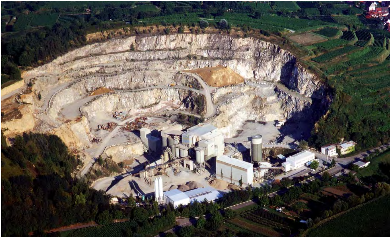
Abb. 99: Gewinnung von zeolithreichem Phonolith im Kaiserstuhl zur Herstellung von Baustoffen mit puzzolanischen Eigenschaften. Phonolithsteinbruch Bötzingen (RG 7912-1).
