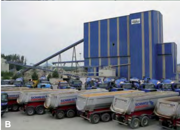
Abb. 167: (A) Nassabbau von locker gelagerten jungen Schottern der Würmeiszeit (Ilmensee- bis Hasenweiler-Formation) mit einem modernen Schwimmbagger. (B) Aufbereitung und Verarbeitung im angeschlossenen Werk mit Logistikzentrum. Kiesgrube Singen (Hohentwiel)-Friedingen im Stadtwald Radolfzell (RG 8219-5) und Werk Radolfzell.
