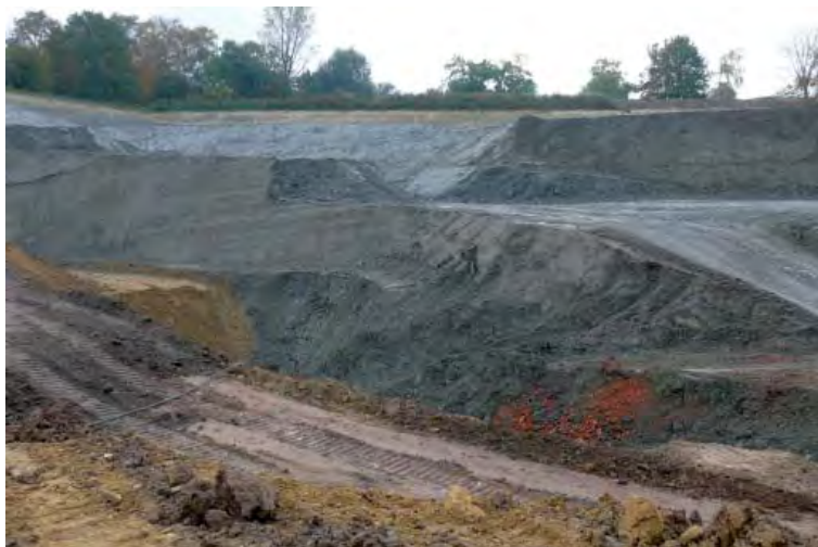
▲ Abb. 142: Abbau von Mergelkalksteinen des Oberen Muschelkalks zur Zementherstellung, Steinbruch Nußloch/Wiesloch-Baiertal (RG 6618-2).
