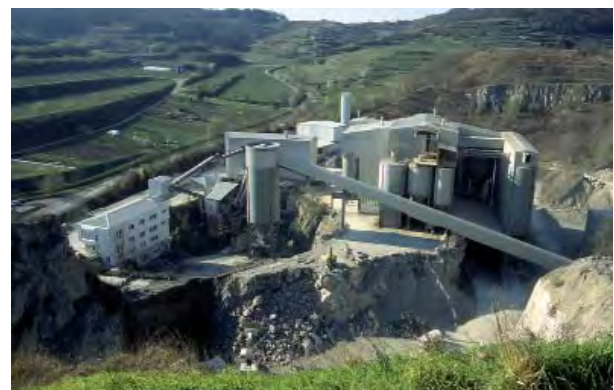
Abb. 159: Mineralstoffwerk bei Bötzingen im Kaiserstuhl; aus dem im angeschlossenen Steinbruch gewonnenen zeolithreichen Phonolith wird eine große Bandbreite an Produkten für Hoch- und Tiefbau, Industrie, Umweltschutz und Landwirtschaft erzeugt.
