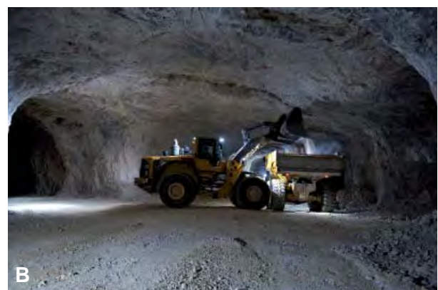
Abb. 117: Aufgrund des Werts hochreiner Kalksteine können diese auch unter Tage gewonnen werden. Bergwerk Mähringer Berg (RG 7525-11): (A) Der Zugangsstollen ist mit Spritzbeton verkleidet. (B) Der Abbau der Massenkalksteine erfolgt im Kammerfestenbau.
