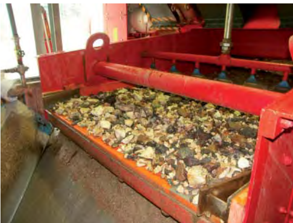
Abb. 135: Aufbereitung in Wolfach: Zu den ersten Schritten gehören Zerkleinern, Reinigen und Sortieren des angelieferten Förderguts.
