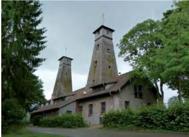
Abb. 126: Gewinnung von Sole für balneologische Zwecke in Bad Dürrenheim, Soletürme (RG 7917-5).
