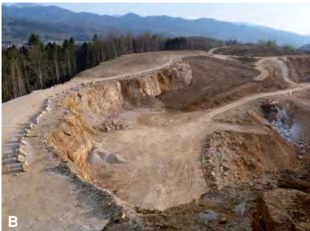
Abb. 156: Kalksteingewinnung in der Vorbergzone südlich von Freiburg: (A) Abbau bei Bollschweil zur Erzeugung von Branntkalk (RG 8012-1; Foto 2009). (B) Der 1920 zur Branntkalkherzeugung angelegte Steinbruch wurde im Jahr 2011 stillgelegt; seine Zukunft ist ungewiss. Große Teile des Steinbruchs sind bereits rekultiviert (Foto März 2012).
