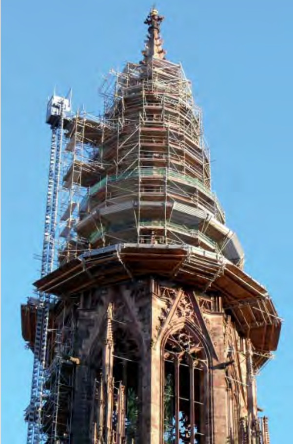
Abb. 42: Turmbaustelle am Freiburger Münster.
