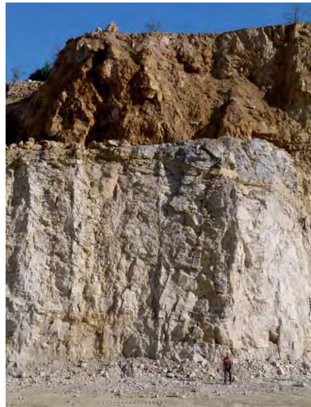
Abb. 14: Eine große Rolle bei der Aufnahme von Steinbrüchen spielt neben der Untersuchung des gewonnenen Rohstoffs auch die Ermittlung der nutzbaren Mächtigkeiten und der Abraumschichten, die im gezeigten Beispiel kräftig braun erscheinen. Kalksteinbruch im Oberjura bei Hülen, Ostalb (RG 7127-1).
