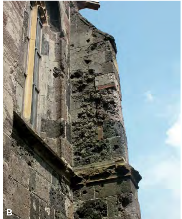
Abb. 32: Das Münster St. Stephan, bedeutende romanisch-gotische Basilika auf dem Breisacher Münsterberg über dem Rhein: (A) Totalansicht von Westen, nach der vollständigen Sanierung (Foto 2011). (B) In Folge von Kriegseinwirkungen und durch Frost stark geschädigter Strebe Pfeiler aus Kaiserstühler Tuffstein, Breisacher Münster vor der Sanierung (Foto 2003).
