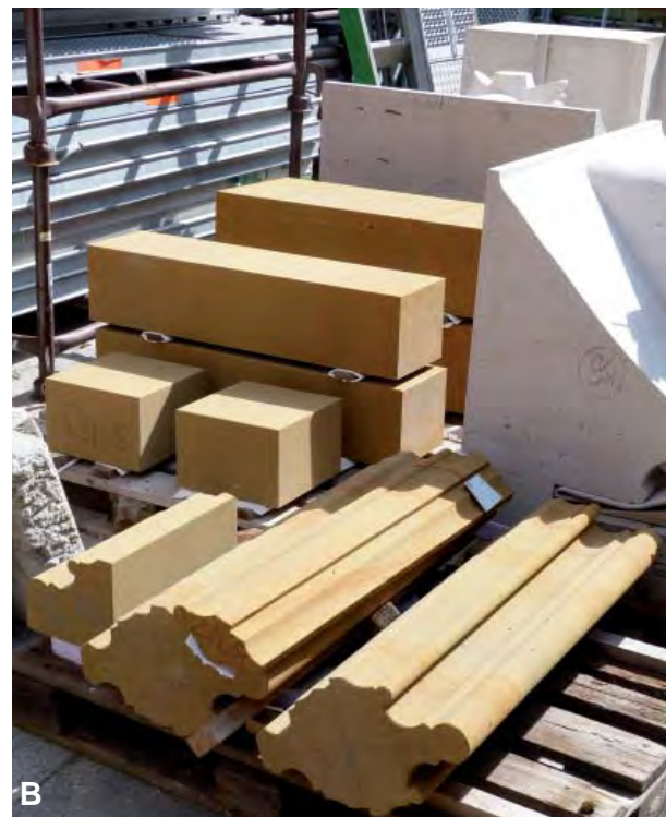
Abb. 40: Rohblöcke aus Lauchheimer Eisensandstein: (A) Blocklager im Werk der Bamberger Natursteinwerke Hermann Graser; dort erfolgte zunächst die Probenahme für die gesteintechnischen Untersuchungen, dann die Vorfertigung der Blöcke für die Münsterbauhütte Ulm. (B) In der Münsterbauhütte Ulm im Jahr 2012 erstellte Werkstücke aus Lauchheimer Eisensandstein kurz vor dem Einbau am Chorbau des Ulmer Münsters.
