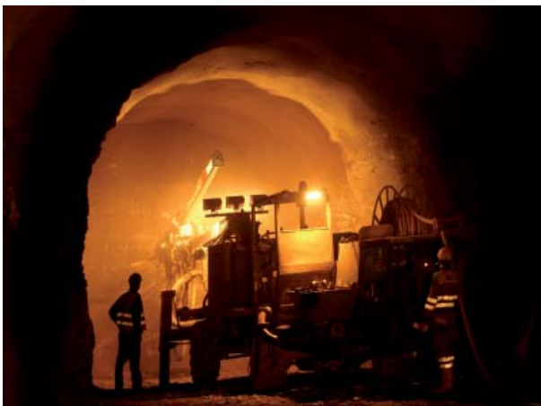
Abb. 10: Das LGRB ist auch für die bergbehördliche Aufsicht über untertägige Hohlraumbauten zuständig; im Bild der Rampenvortrieb im Salzbergwerk Stetten, 2008.
