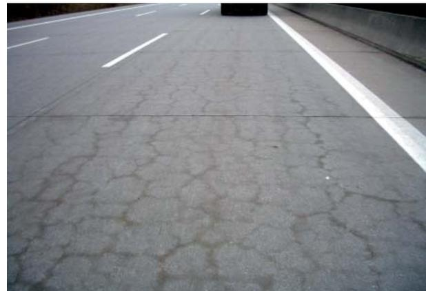
**Abb. 218:** Rissbildung in einer Fahrbahndecke, ausgelöst durch die Alkali-Kieselsäure-Reaktion (Foto: Landesstraßenbaubehörde Sachsen-Anhalt).
