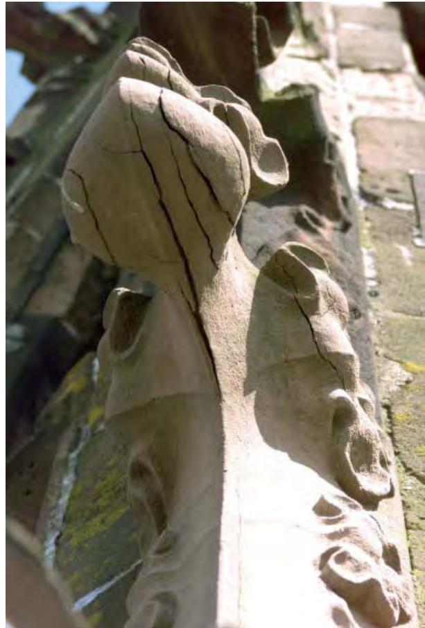
Abb. 43: Stark geschädigte Krabbe am Turmhelm des Freiburger Münsters; dieser unter den herrschenden Witterungsbedingungen nicht geeignete Feinsandstein aus Steinbrüchen bei Freudstadt war erst in der Mitte des 20. Jh. eingebaut worden; der umgebende Sandstein aus den Steinbrüchen bei Tennenbach zeigt sich hingegen seit über 700 Jahren stabil gegen Witterung und statische Beanspruchung.
