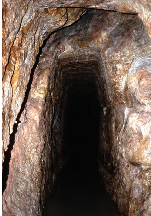
▲ Abb. 75 Mit Schlägel und Eisen aufgefahrener Stollen mit kastenförmigem Querschnitt.
