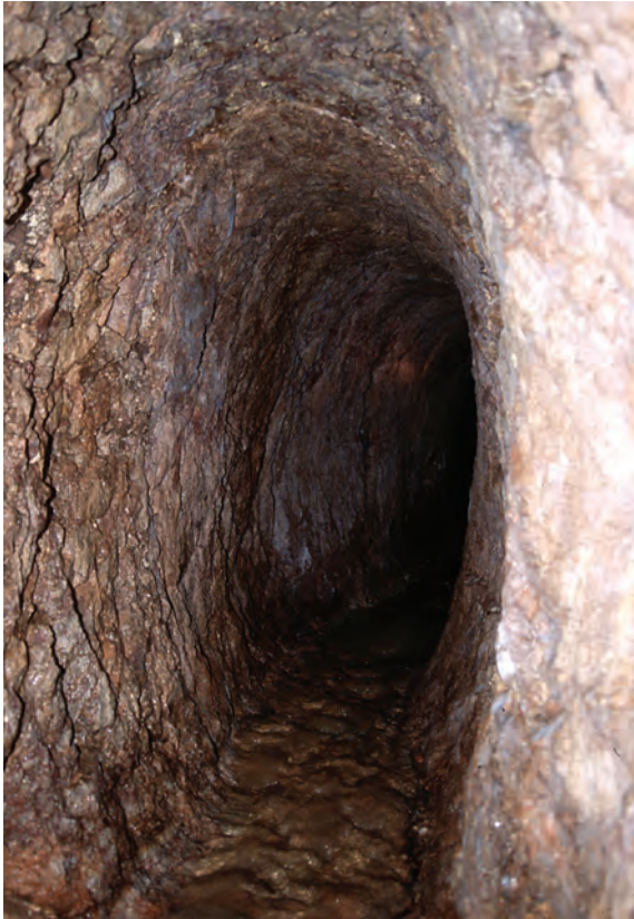
▲ Abb. 74 Mit Schlägel und Eisen aufgefahrener Stollen mit ovalem Querschnitt.
