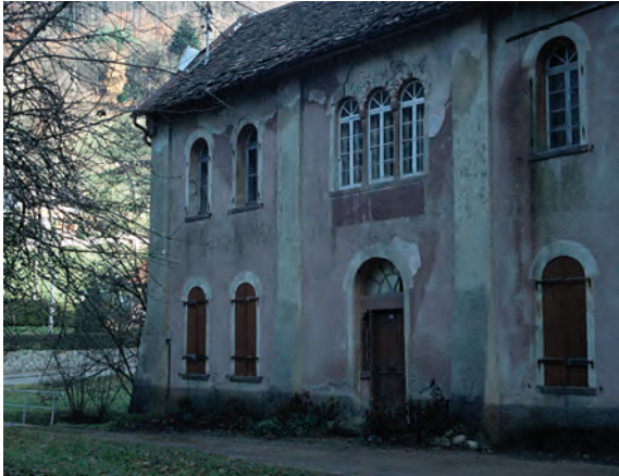
▲ Abb. 100 Ehemaliges Pochwalzwerk der Grube Teufelsgrund, errichtet 1835 (Foto 2003).
