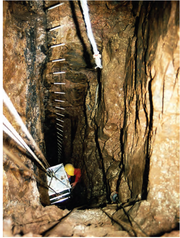
▲ Abb. 106 Herrichtungsarbeiten unter Tage.
