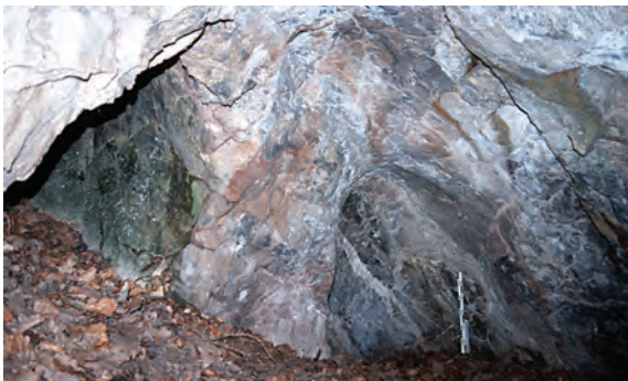
▲ Abb. 103 Feuergesetzte Abbauhohlräume im Bergbaugebiet am Badenweiler-Quarzriff.
